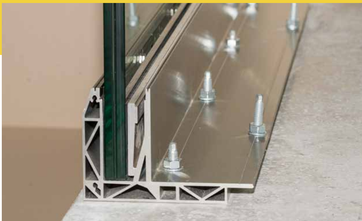
La latte de serrage est bien visible.
